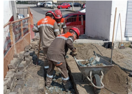
Trabalhadores da Light estão concluindo as instalações novas
