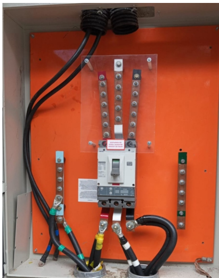
Os novos medidores de energia já estão sendo instalados
