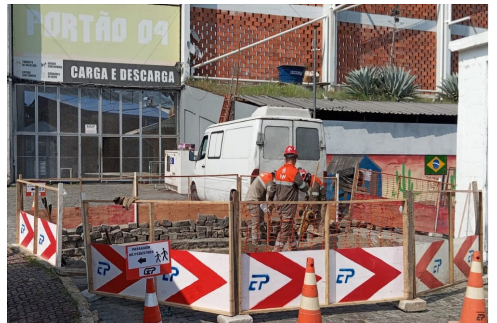
A Light entra no processo final de instalação dos medidores de energia
